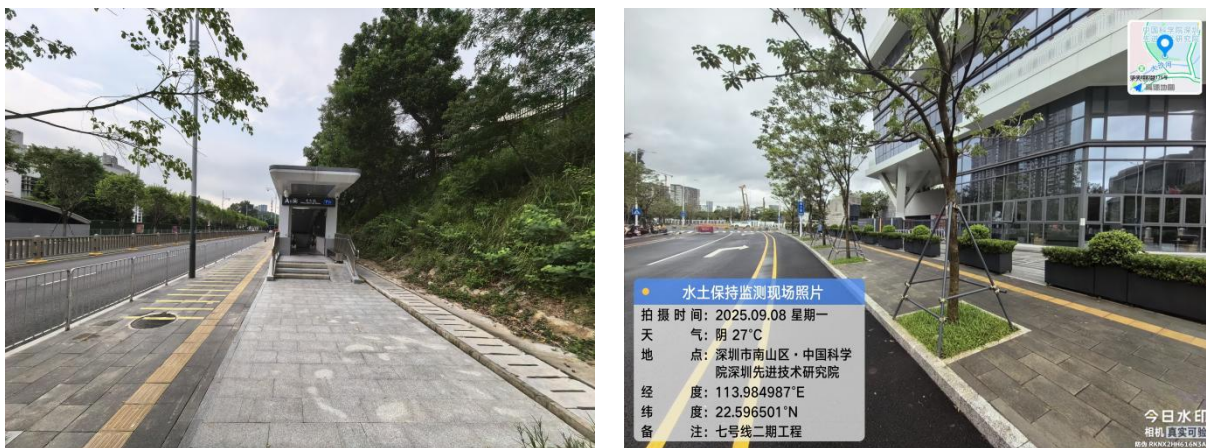
图 4-1 工程实施的人行道透水铺装
