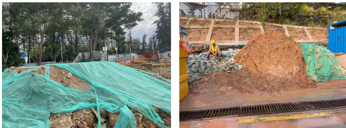
图 3-3 施工过程中临时堆积的弃土
