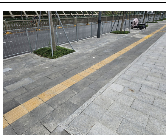
图 4-4 人行道透水铺装
