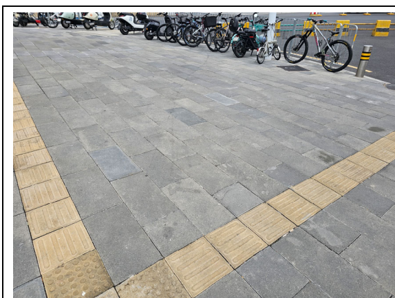
图 4-1 人行道透水铺装
