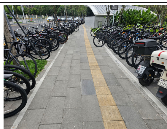
图 4-2 人行道透水铺装
